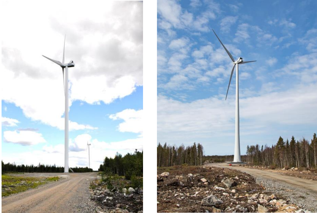
Kuva 22. Vasemalla on esimerkki teräslieriötornista ja oikealla hybriditornista. (Kuvat: Leila Väyrynen ja Ville Suorsa, FCG)
