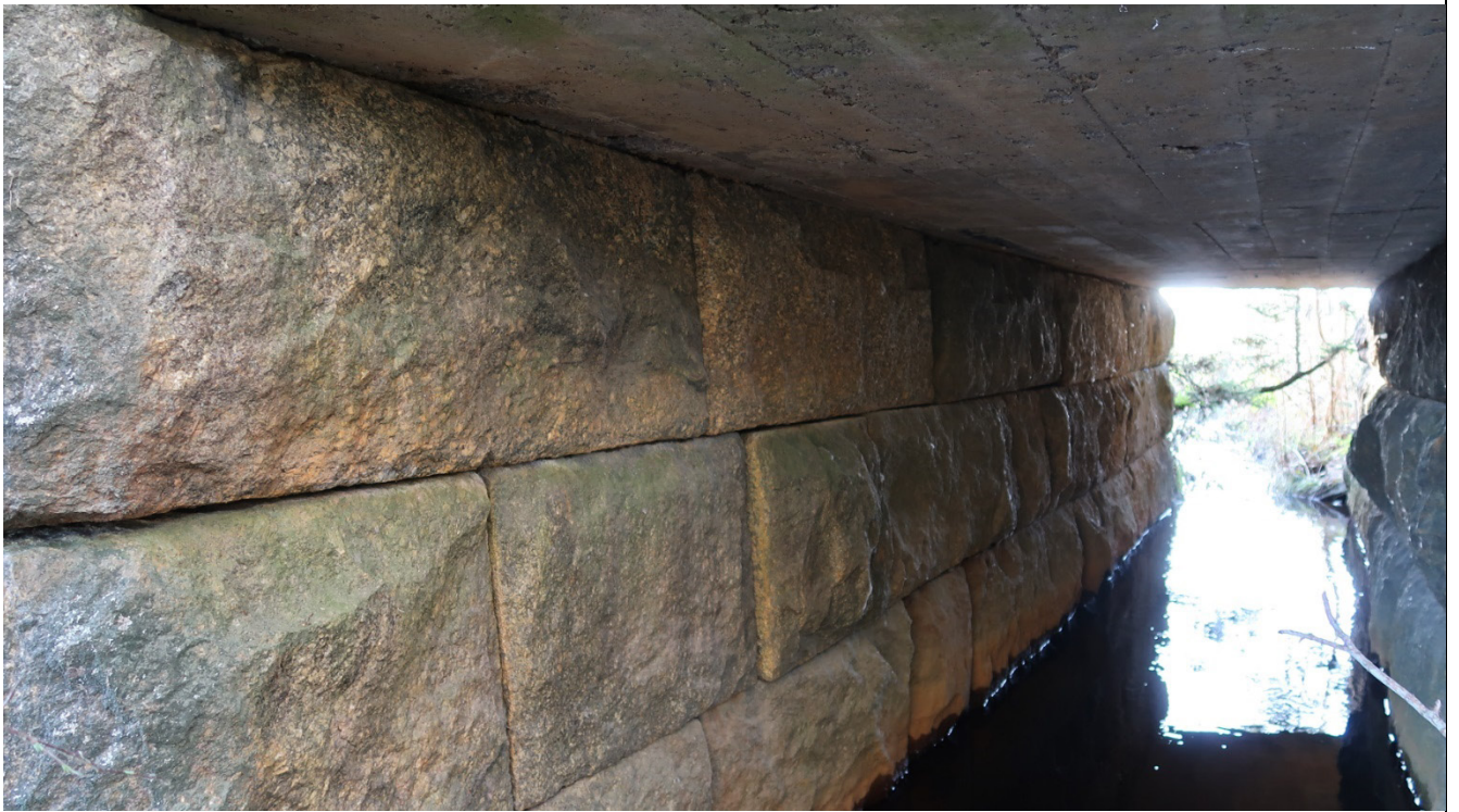
Sillan alapuoli. Maatuet ovat suoraseinäiset.
