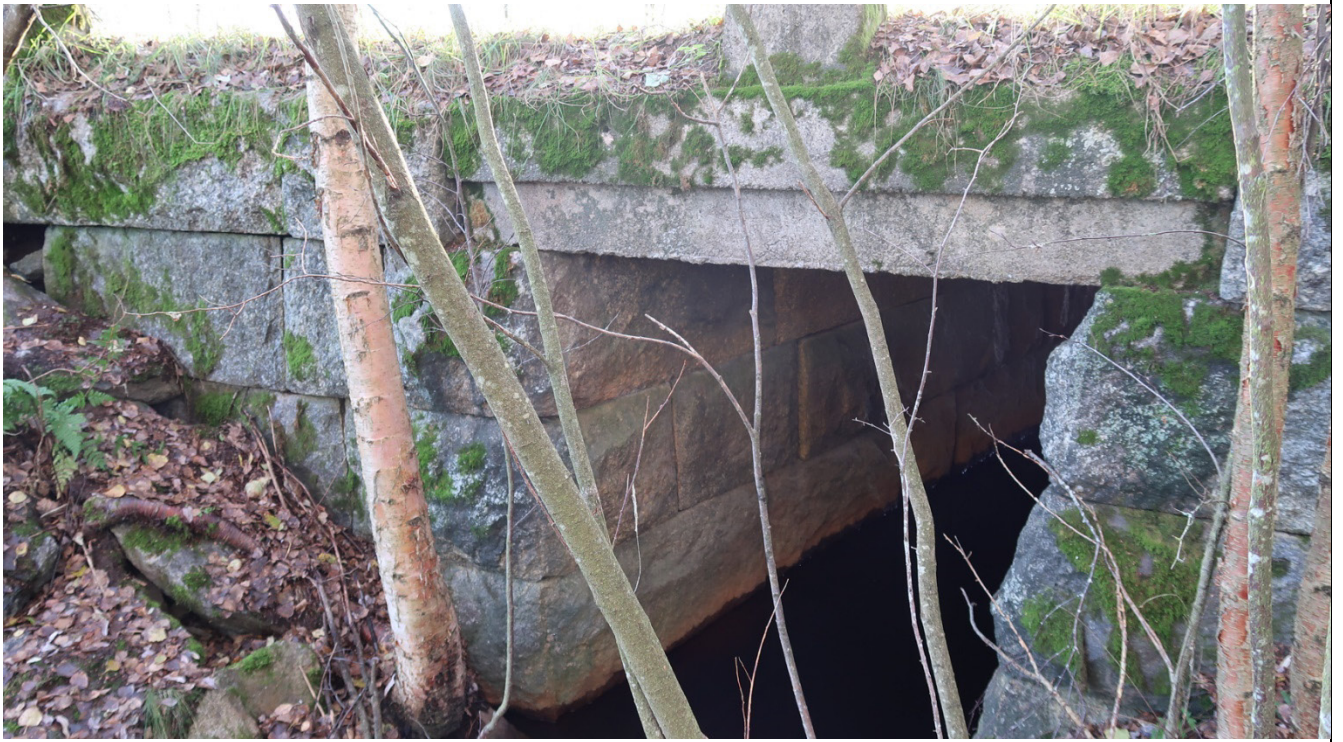
Sillan aukko on kapea. Sillassa on betonikansi.
