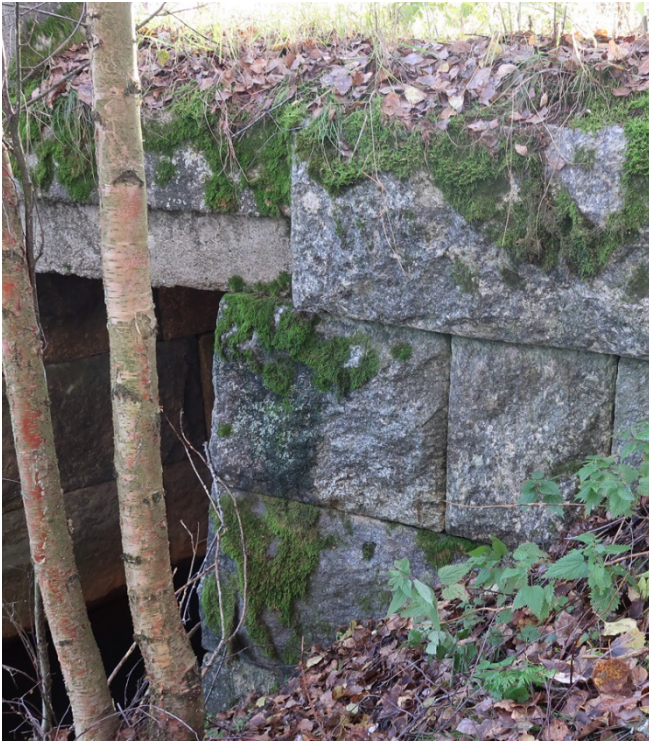
Sillan rakennetta pohjoispuolella.
