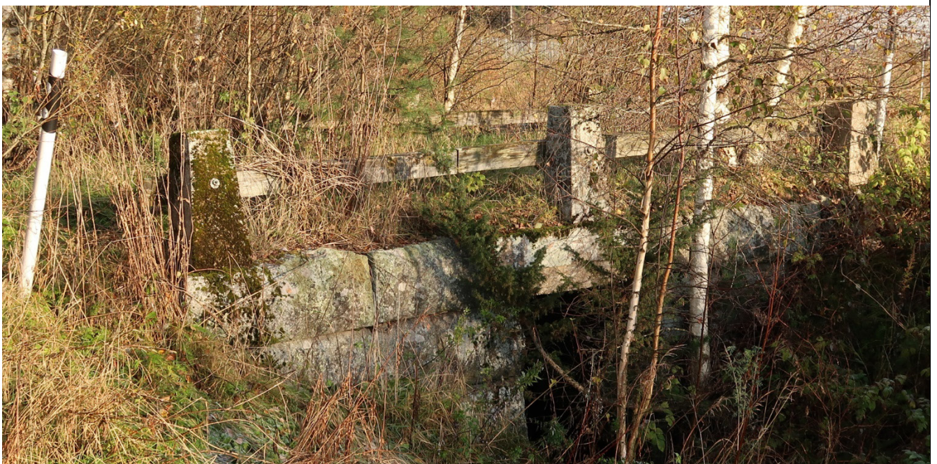
Sillan eteläpuoli. Puiset kaiteet on kiinnitetty kivisiin pylväisiin.
