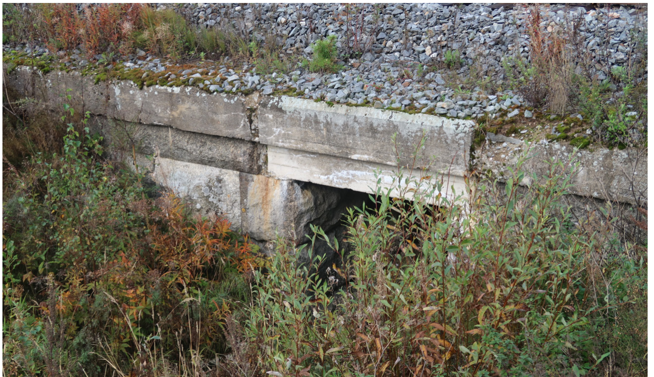
Rautatien alittavan ojan silta Suupohjan radan varresta välillä Seinäjoki-Ilmajoki Ahonkylän kohdalla. Sillassa on sekä kivisiä että betonisia rakennusosia. Suupohjan rata on rakennettu 1910-luvulla (Kuvaaja T. Tarkkanen 2021)
