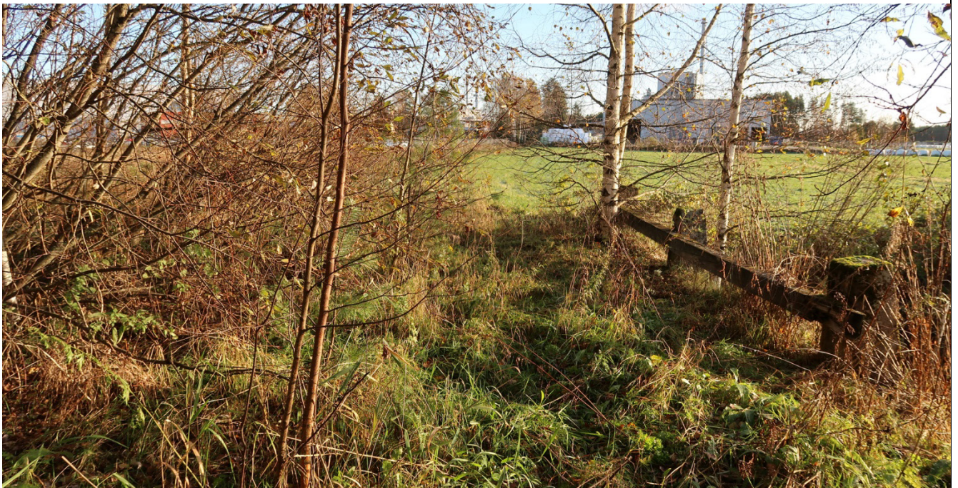
Näkymä sillan yli koilliseen.
