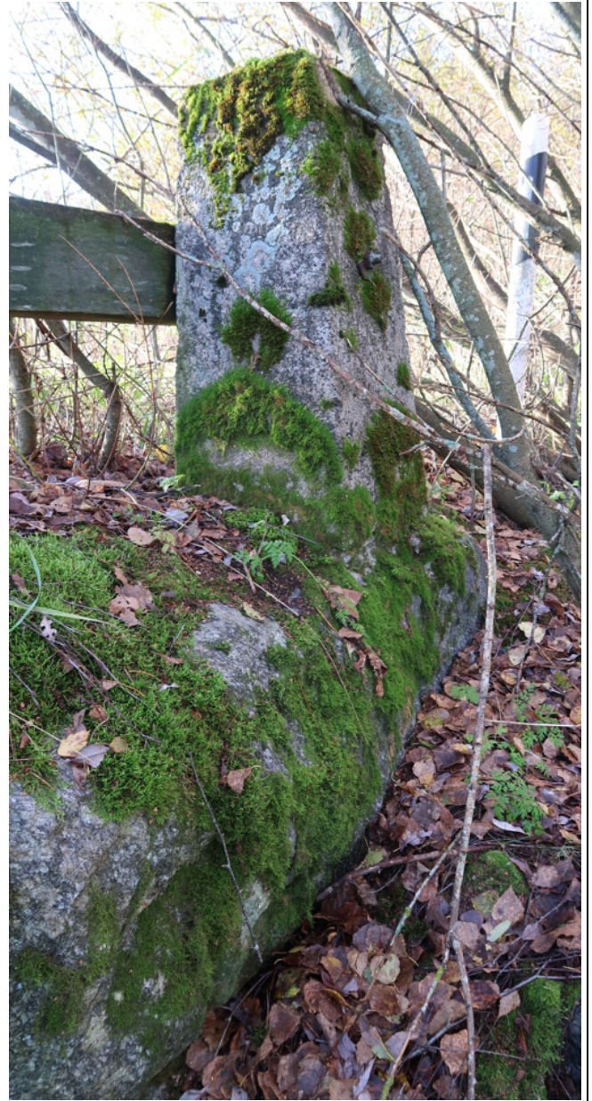
Puiset kaiteet on kiinnitetty kivisiin ylöspäin kapeneviin kaidepylväisiin.
