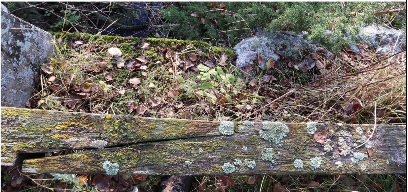
Puinen kaiderakenne ylhäältäpäin. Kaiteen jatkoskohta.
