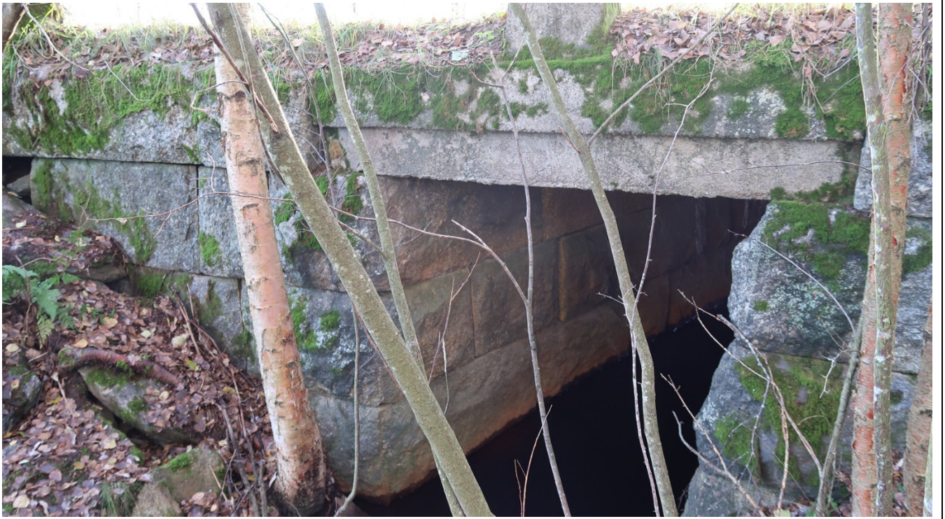
Öppningen i bron är smal. Bron har ett betonglock.
