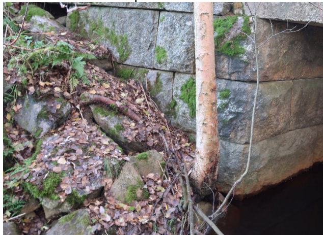
Bredvid bron finns stödslänter av sten.
