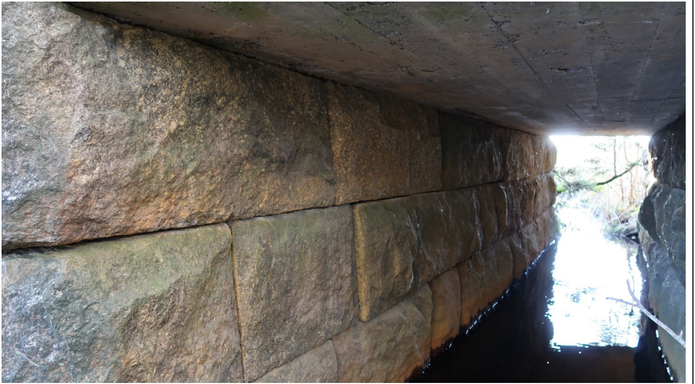
Undersidan av bron. Landfästena har raka väggar.
