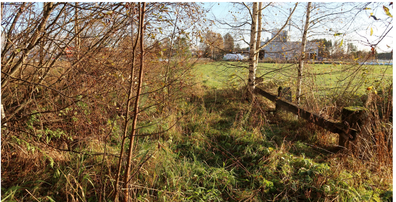
Vyn över bron mot nordost.
