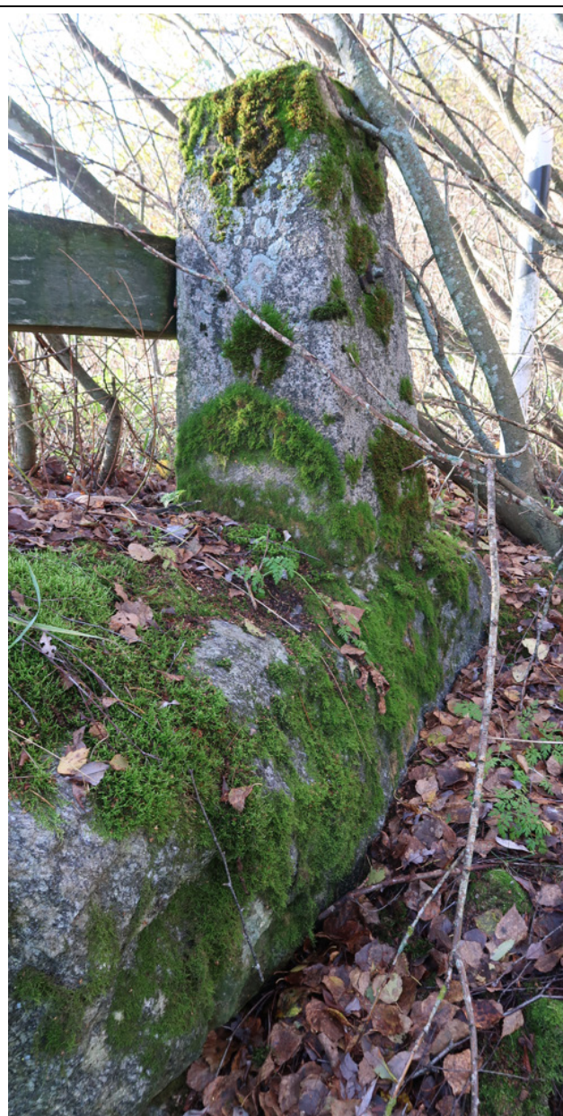
Träräckena är fästa i de uppåt smalnande räcketstolparna av sten.
