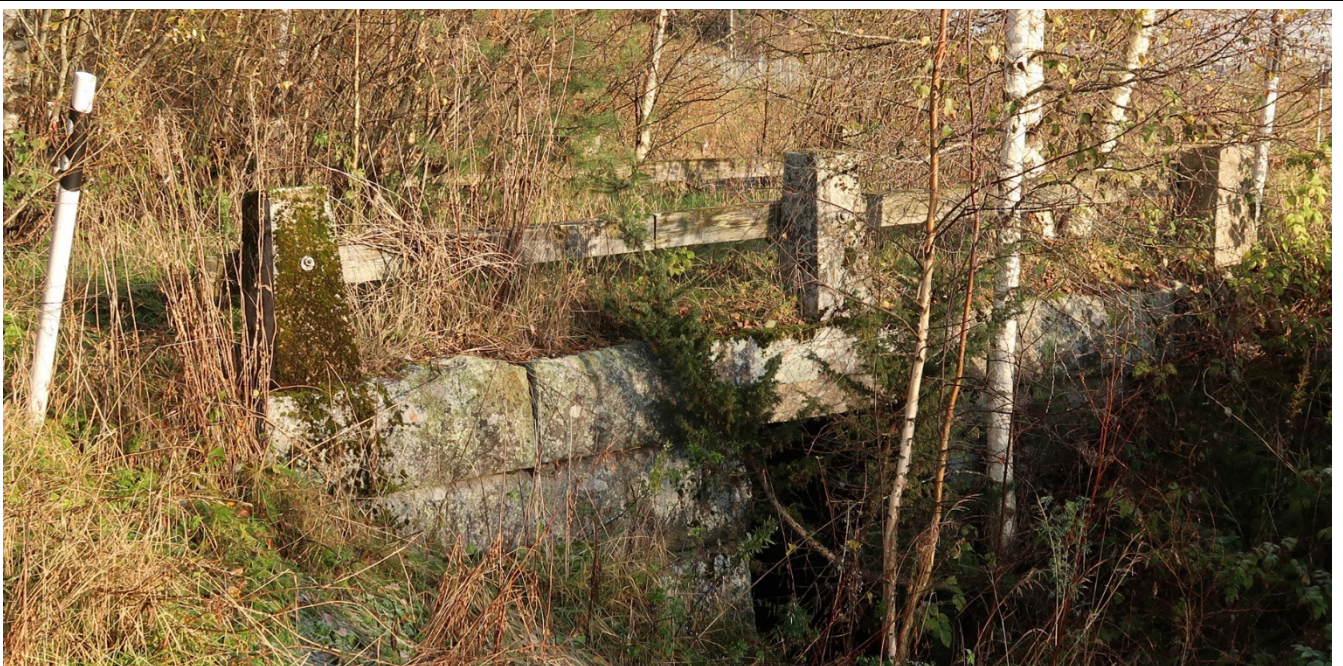
Bron från sydsidan. Träräckena är fästa i stenspelarna.
