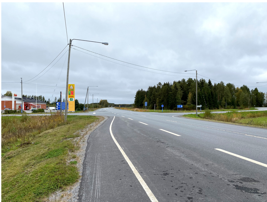
Bild 25. Korsningen Ekolavägen-Pensalavägen som kommer beröras av trafikregleringar i framtiden.
