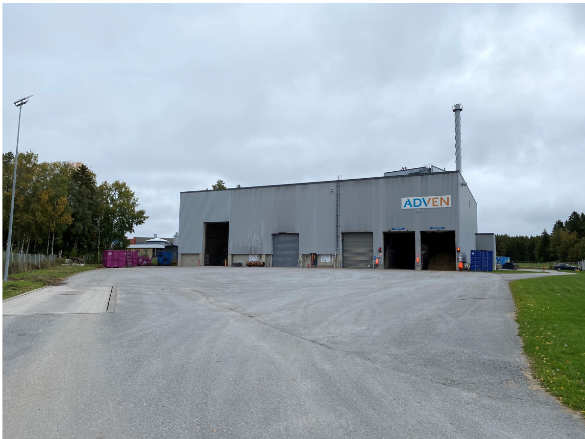
Bild 10. Befintlig värmecentral invid Kiitolavägen.
