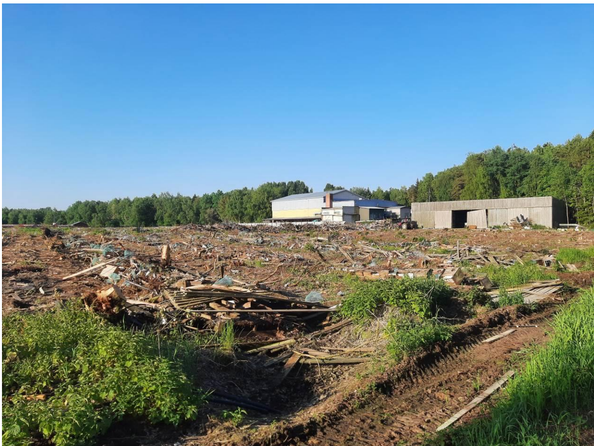
Bild 3. En stor del av det inventerade området (figur 1) består av ett gammalt farmområde som är i olika stadier av avveckling och nedmontering.
