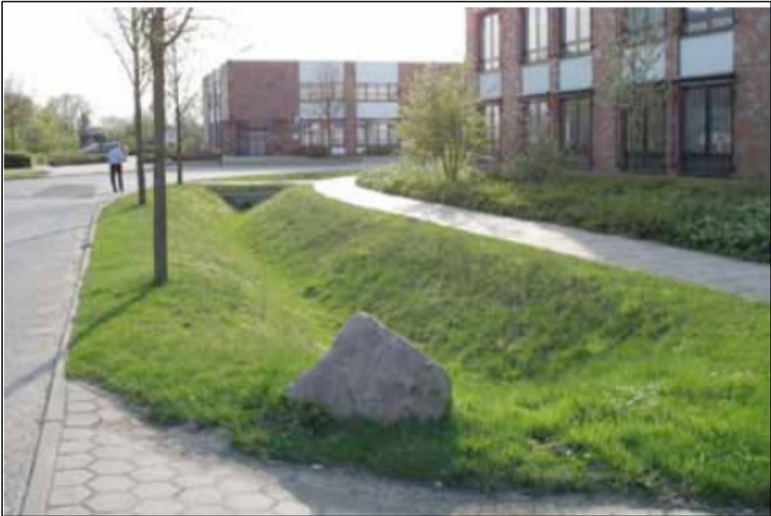
Figur 13. Exempel på ett dike med grönt växttäck (Hulevesiopas 2012)
