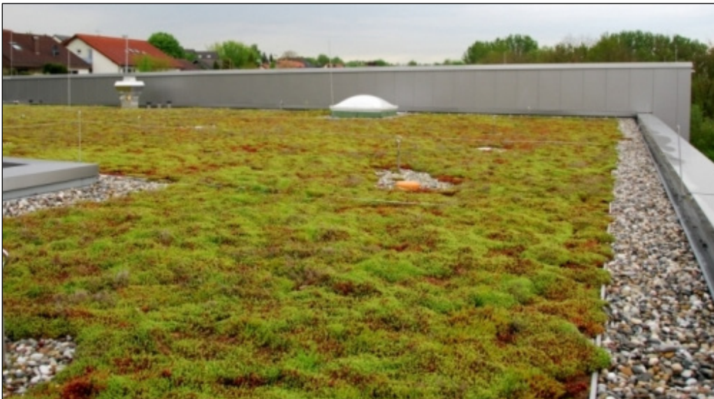
Kuva 12. Esimerkki viherkatosta (Envire Oy)
