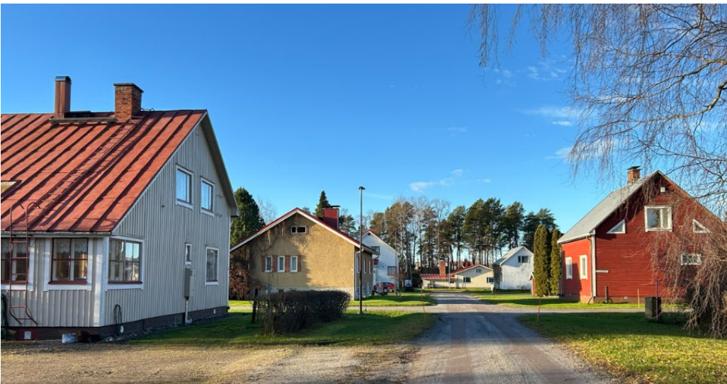
Figur 10. Byggnadsbeståndet längs Karl Grönforsgatan. Fotat mot väster. © Plandea Oy
