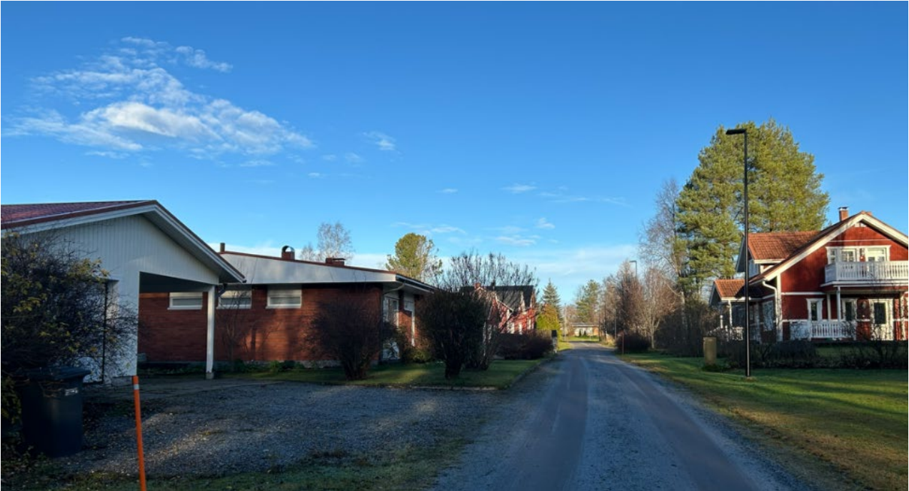
Kuva 11. Itälän varren rakennuskantaa suunnittelualueella. © Plandea Oy
