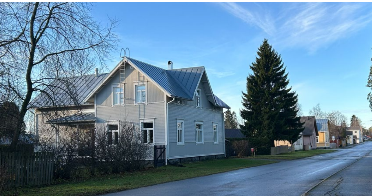
Kuva 14. Ratakadun varren rakennuskantaa suunnittelualueella. © Plandea Oy
