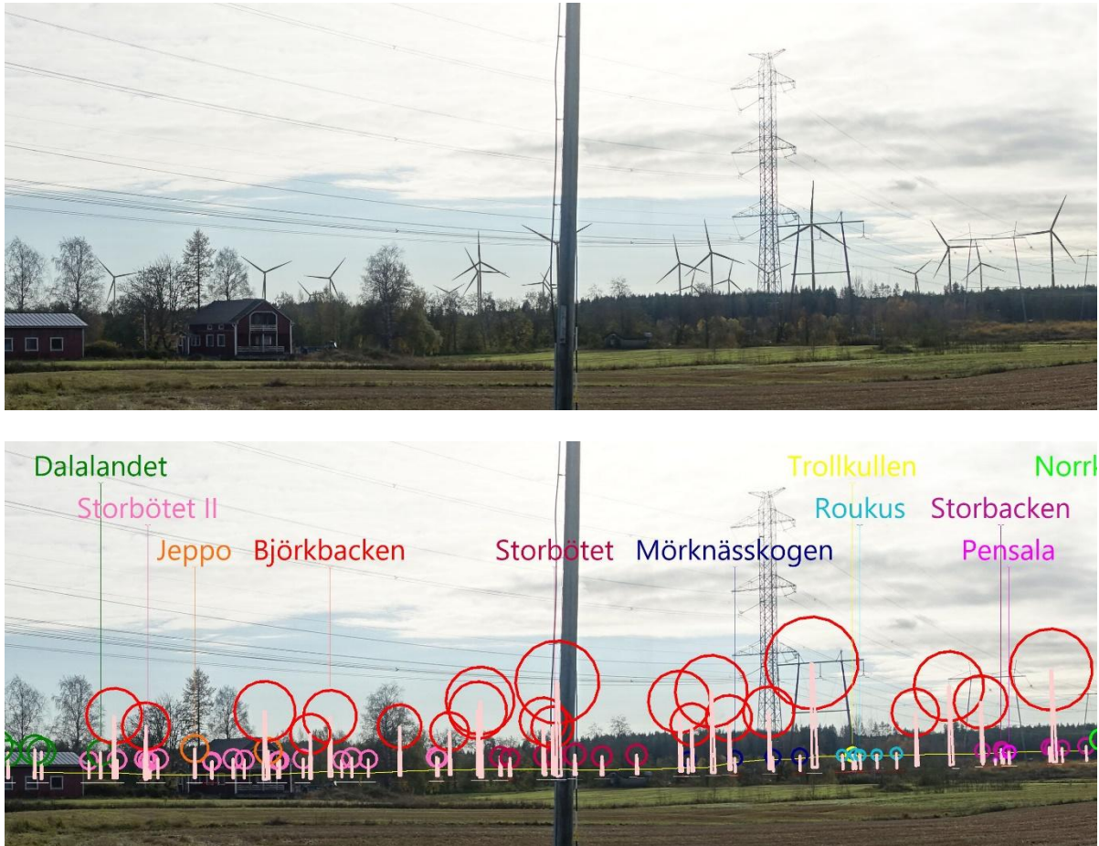
Kuva 54. Havainnekuvat (polttoväli 50 mm) tuulivoimaloiden sijoittumisesta maisemaan koillisesta, Ytterjepuan kylän suunnasta katsottuna (kuvauspiste 7). Selkeyden vuoksi havainnekuvista on esitetty myös ns. rautalankamalli, jossa tuulivoimaloita on korostettu värillisinä havainnollisuuden lisäämiseksi. Etäisyys lähimpiin tuulivoimaloihin (Björkbacken) on noin 3 km ja kauimmaisiin (Roukus) n. 24 km.
